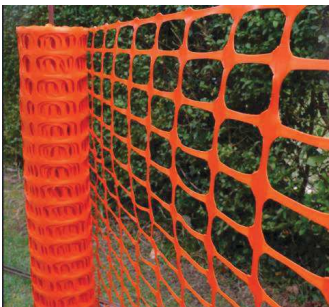
Fig. 11. Délimitation d'un chantier.
